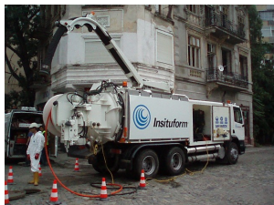
Operațiune de spălare a canalizării
