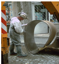
Operațiunea de pregătire a rigolei înainte de introducerea acesteia în canalizare și fixarea în poziție
