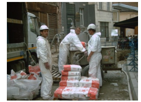
Imagini din timpul operațiunii de injectare a mortarului cimentos
